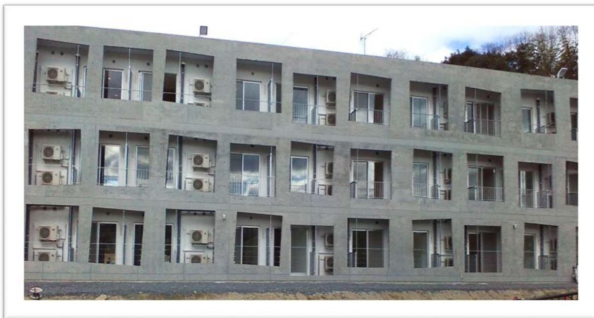
【成安造形大学学生専用アパートメント [YOHAYU] 外観】
